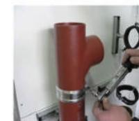
4、使用螺絲扳手、棘輪或常用電動螺絲起子鎖緊內六角螺絲。
