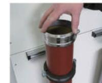
2、將卡箍完全移動到管的末端或密封墊片中間。
